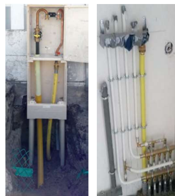
Installations de kits PLT : Sortie de coffret et préparation d'alimentation chaudière
